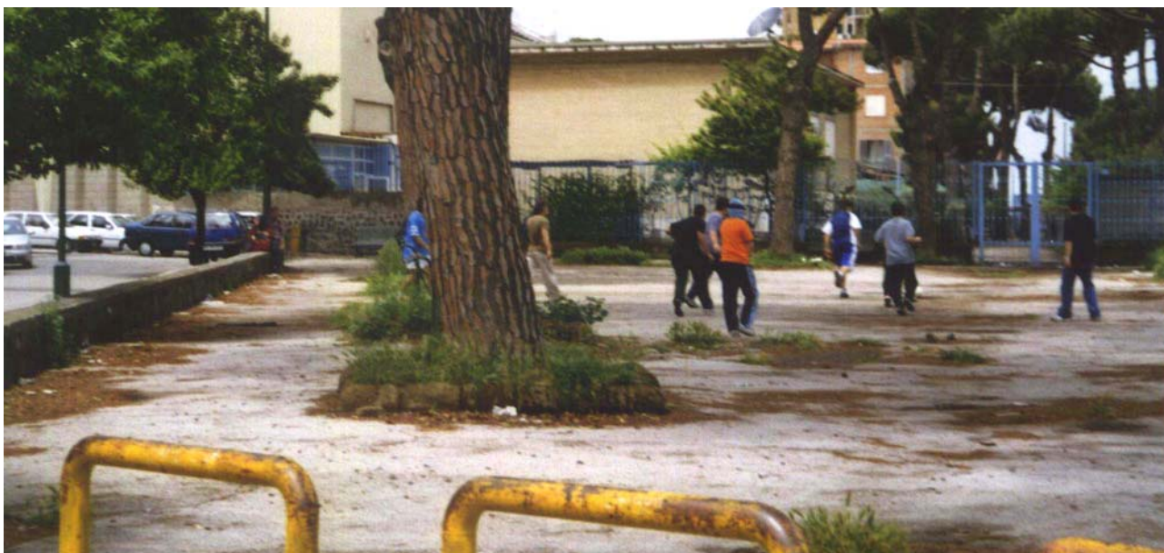
Figura 4 – L'area antistante il centro polisportivo INA-Casa. Anche in questo caso, nonostante l'evidente incuria, i ragazzi fanno uso di tale spazio per i loro giochi. L'uso di spazi inadeguati, perché privi di manutenzione, e spesso per questo pericolosi, è indicativo di quella già citata assuefazione a standard di vita e di servizi bassi, che in alcuni casi può portare alla non-percezione di determinati bisogni.
