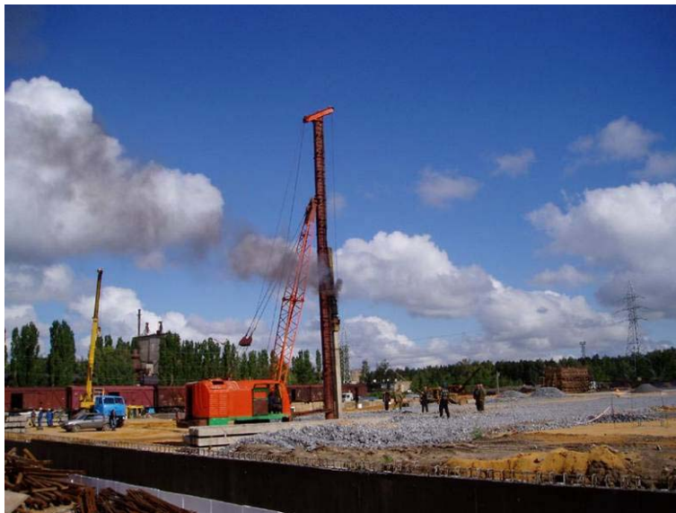
Lipetsk, complesso Stinol. Primo palo per il nuovo stabilimento di lavabiancheria (Fonte: Merloni Progetti spa Milano, 2003)
