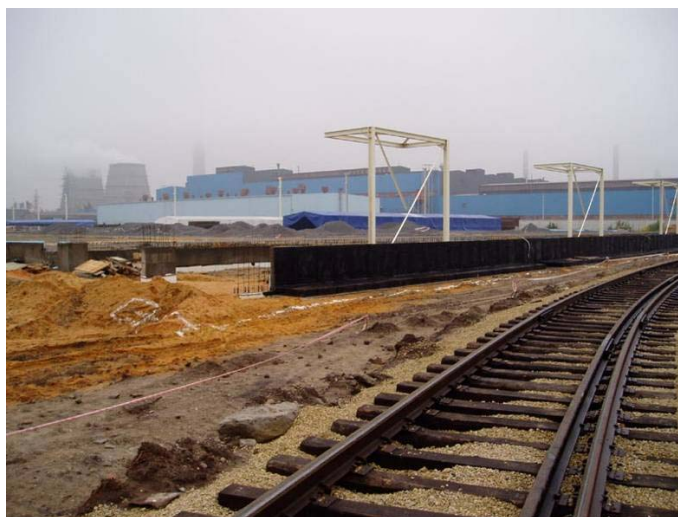
Lipetsk, cantiere per la costruzione del nuovo stabilimento di lavabiancheria Stinol (Fonte: Merloni Progetti spa Milano, 2003)
