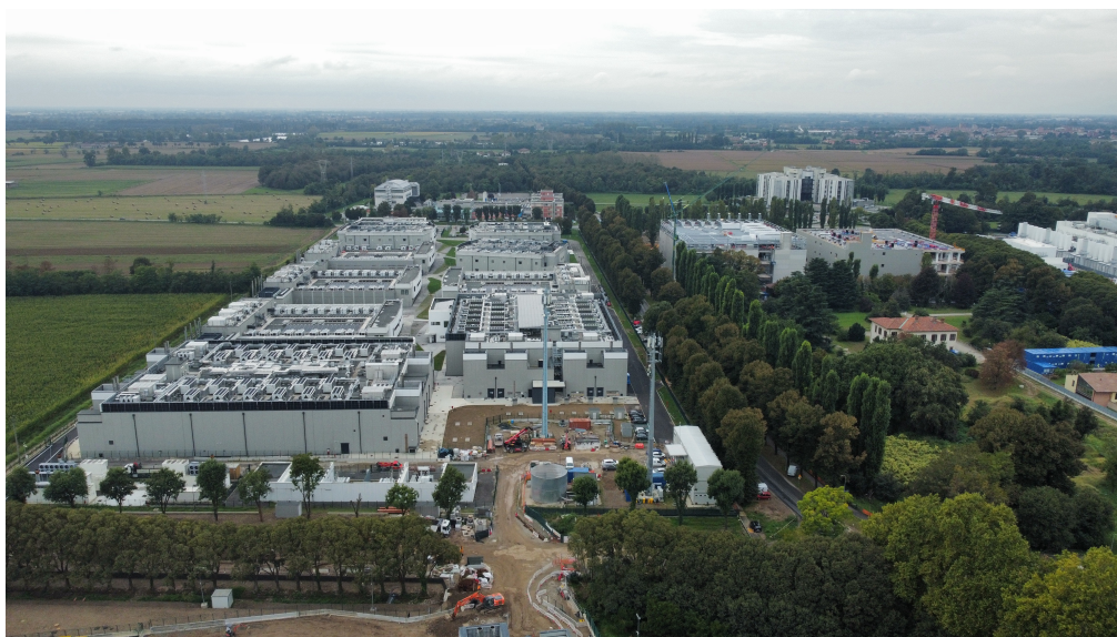
Figura 3 | L'area dei Data Center di Settimo Milanese (MI).
