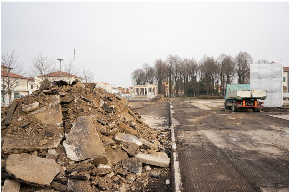
*Figura 3* | Nei processi di riscrittura della città, i processi di demolizione sono elemento progettuale. Avvio del riciclo dei materiali da demolizione come sottofondi nel progetto della nuova piazza di Albignasego
